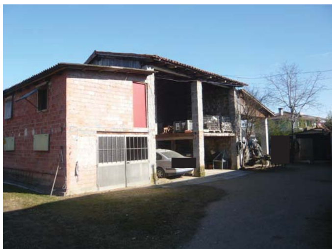
deposito attrezzi e fienile – lato sud
