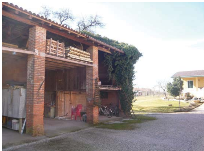
deposito attrezzi e cantina – lato nord
