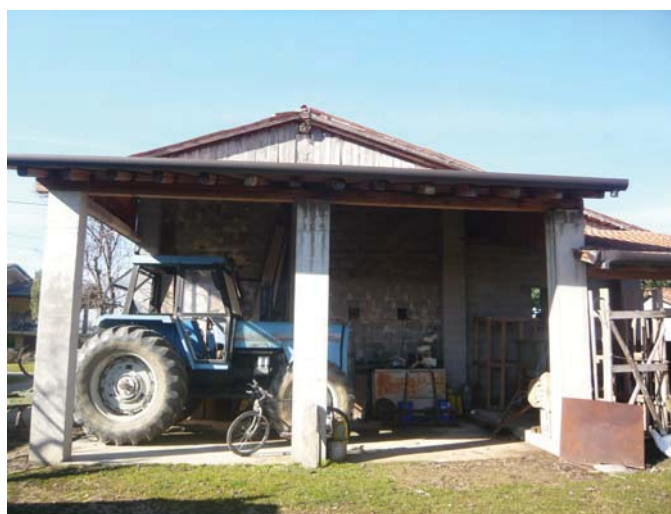
deposito attrezzi e fienile – lato est
